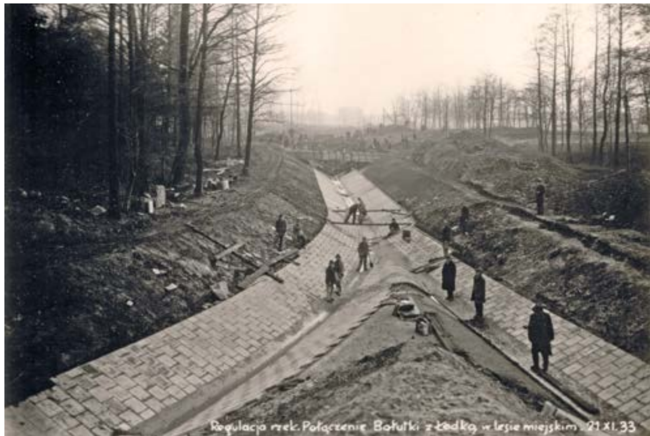
16. Budowa kanału rzek Łódki i Bałutki, rok 1933
