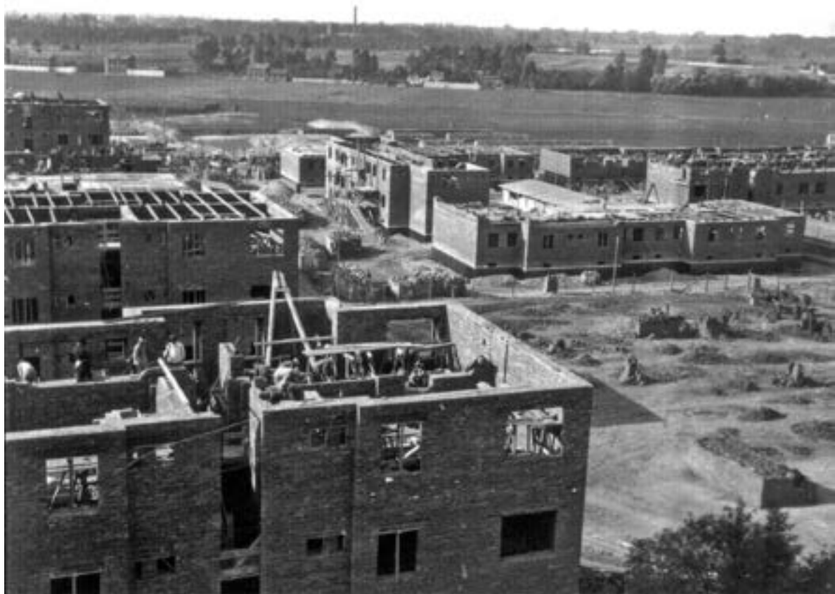
1. Osiedle w trakcie budowy
