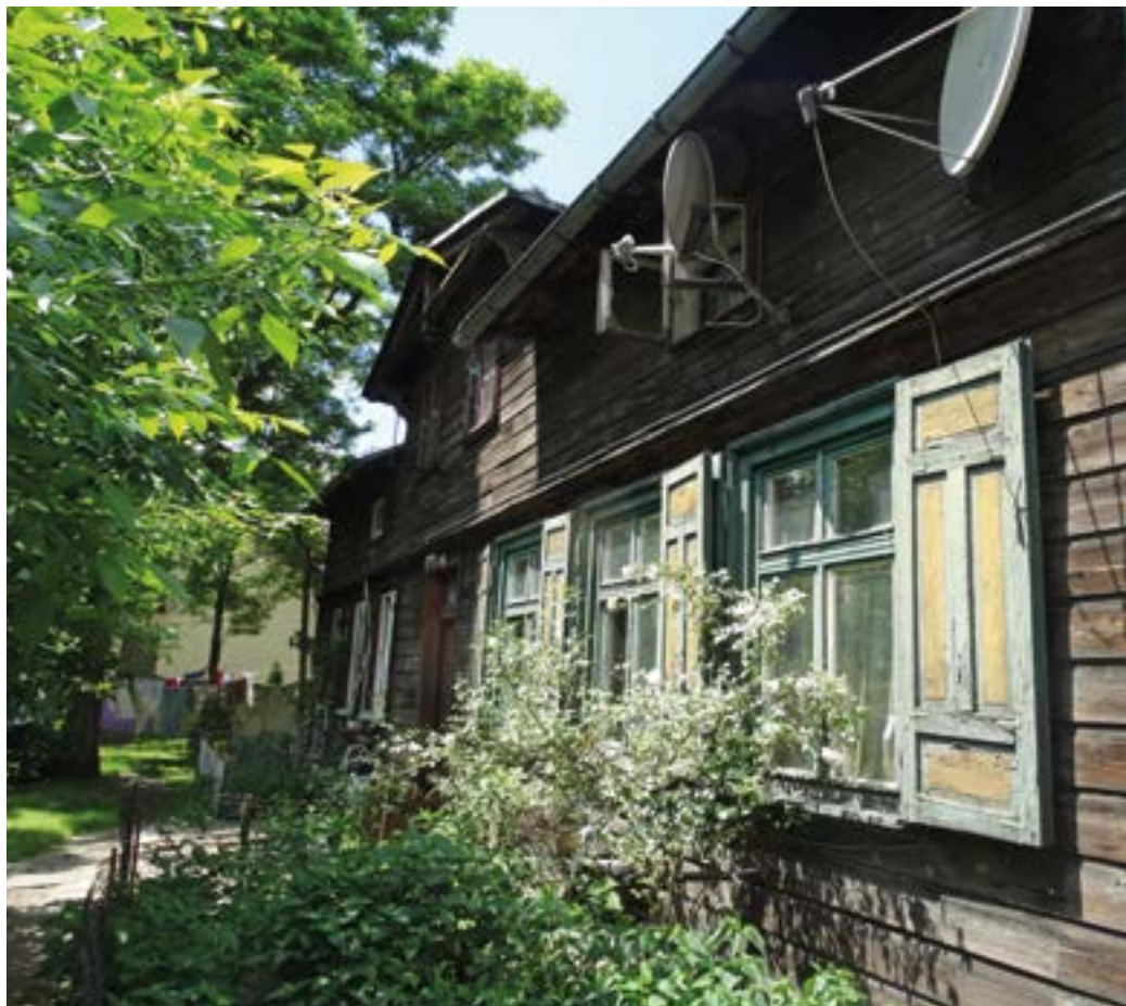
4. Przedwojenny drewniany dom przy ul. Złotno 11
