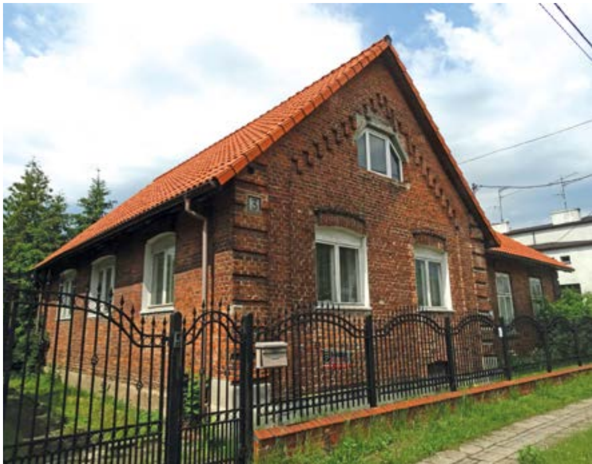
15. Budynek dawnej szkoły przy ul. Płatowcowej 3
